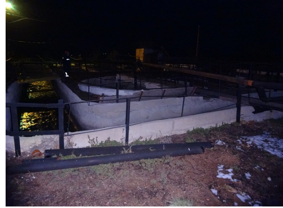
下水処理場沈でん池
